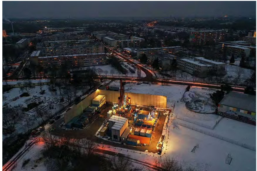
Tiefen-Geothermie: Die Injektionsbohrung in Schwerin-Lankow kommt gut voran.
